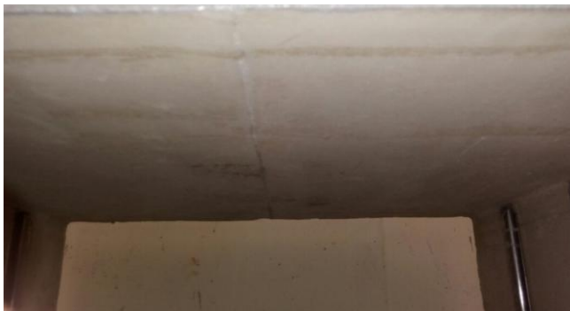
Figura 9- Verificação do Teste de Estanqueidade.
