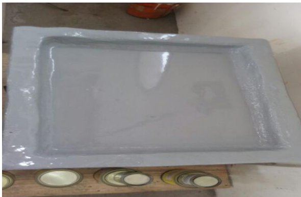
Figura 5- Acabamento da Primeira Camada
