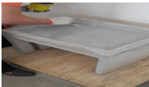
Figura 4- Aplicação da Primeira Camada de Poliuretano (Vulkem 350 Nf-Base Coat)
