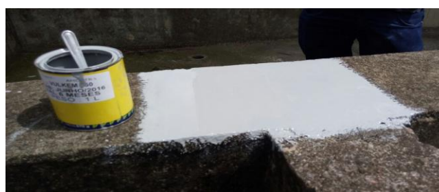
Figura 8- Aplicação do Produto em Vigas e Lajes da Fatec Tatuapé
